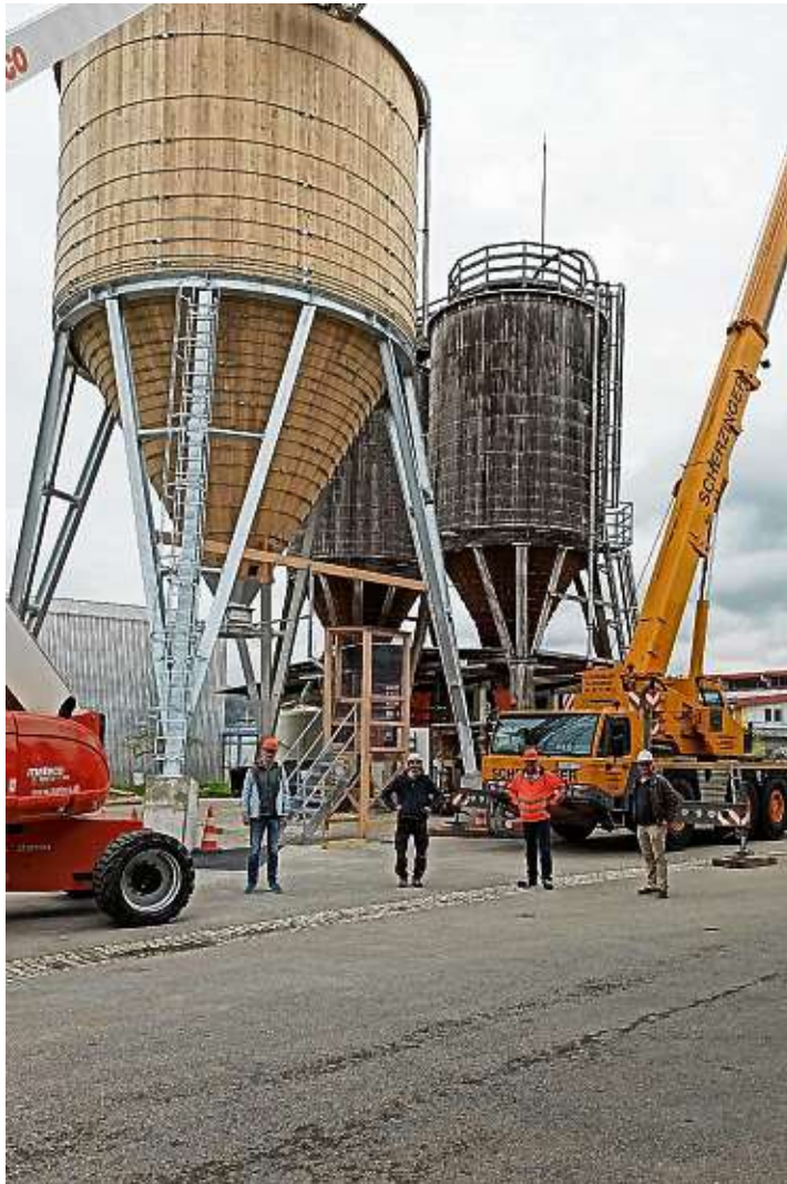
Beim Aufbau des neuen Streusalzsilos dabei waren (von links) Timo Schiess (Straßenbauamt, Landkreis Konstanz), Mitarbeiter der Firma Blumer-Lehmann Silobau, Helmut Hengstler (Straßenmeisterei, Landkreis Konstanz), Andreas Hinder (Amt für Hochbau und Gebäudemanagement, Landkreis Konstanz). Bild: Landratsamt Konstanz
