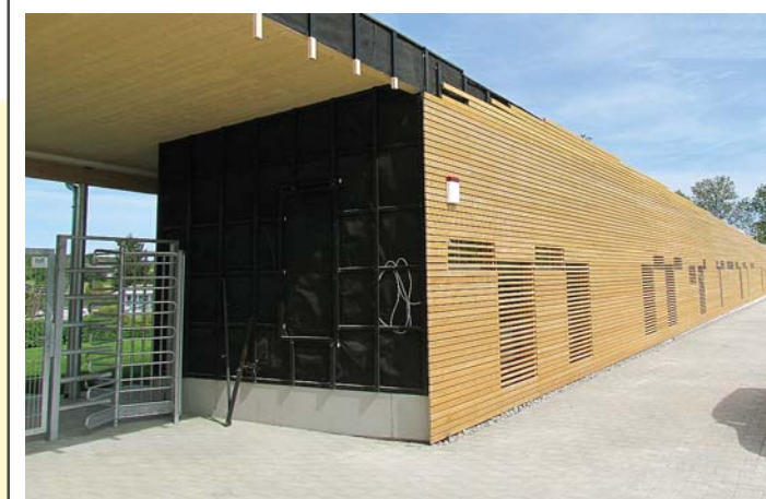
Hinter der Holzfassade des neuen, 102 Meter langen Gebäuderiegels entlang der Mundingstraße ...
