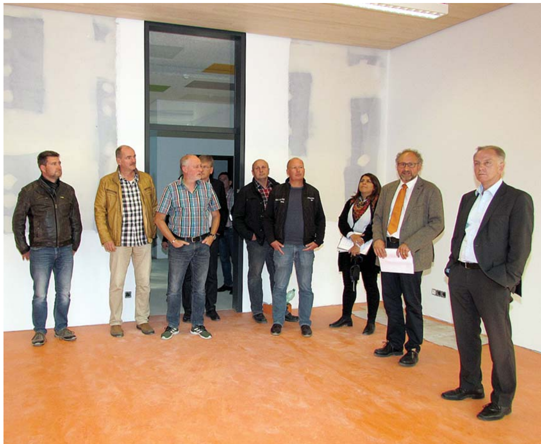
Kurz vor der Fertigstellung und damit dem Umzug mehrerer Klassen steht der Anbau an die Grundschule Engen. Im Rahmen eines Ortstermins verschafften sich die Mitglieder des Technischen und Umweltausschusses (von links) Bernd Keller, Bernhardt Maier, Martin Schoch, Gerhard Steiner (verdeckt), Peter Kamenzin (ganz hinten), Siegfried Ellensohn und Lars Nilson sowie Bauleiterin Sara Moschirian, Stadtbaumeister Matthias Distler und Bürgermeister Johannes Moser am vergangenen Donnerstag einen Eindruck von den neuen Räumen. Bild: Hering
