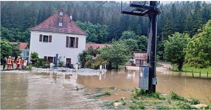
Beim Kriegertalhof drang Wasser in ein Gebäude ein. Bilder: FFW Engen
