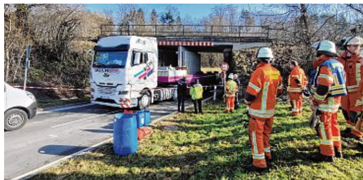
Verkeilt hatte sich die Ladung eines LKW unter der Bahnbrücke über die Lindenstraße zwischen Engen und Neuhausen am 29. Januar. Der mit Betonplatten beladene Transporter blieb unter der Brücke stecken. Die Feuerwehr Engen wurde wegen auslaufender Betriebsstoffe alarmiert und war mit mehreren Fahrzeugen vor Ort, der Bahnverkehr wurde für mehrere Stunden ausgesetzt, da die Statik der Brücke geprüft werden musste. Bild: Rauser
